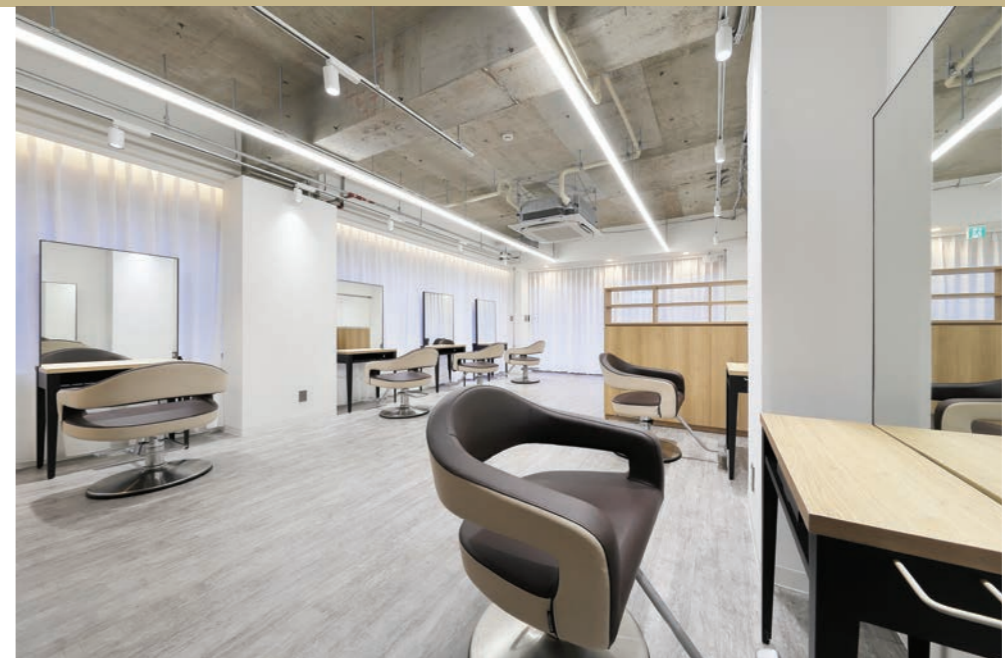
コンクリート打ちっぱなしの天井にあわせて、ダクトレール照明を取り付けている
